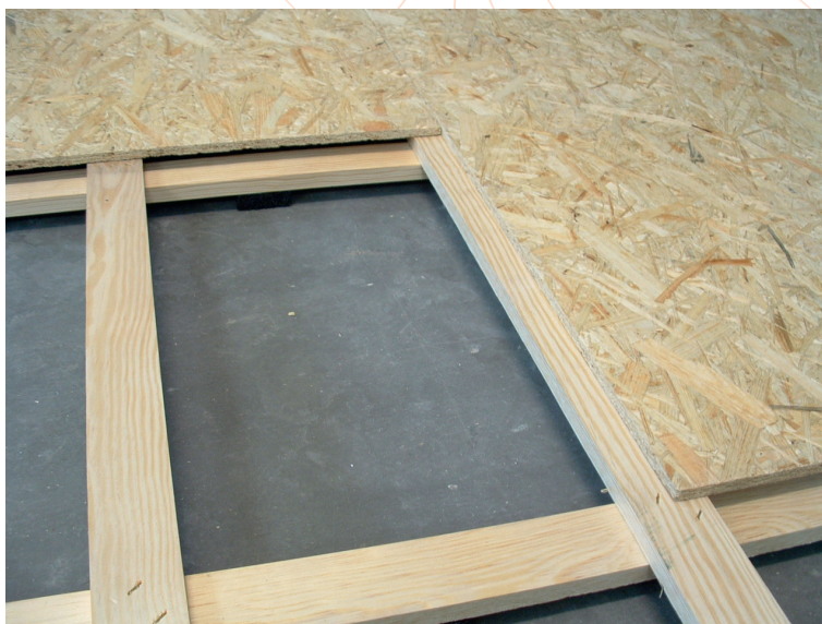
Fot.2. Montaż płyt OSB 3 lub P5 względem listew rusztu.
