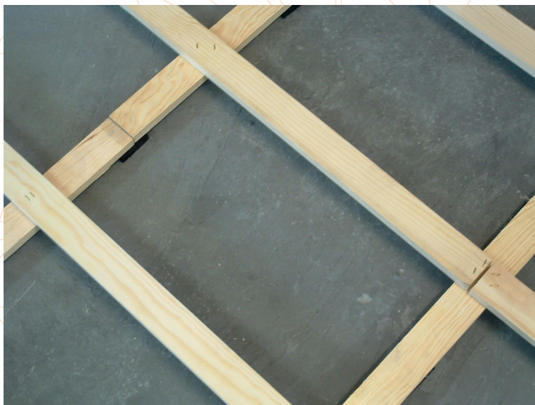
Fot.1. Połączenie listew dolnych z listwami górnymi.
